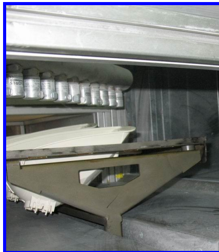
Obr. 4: Ofukovací trysky
