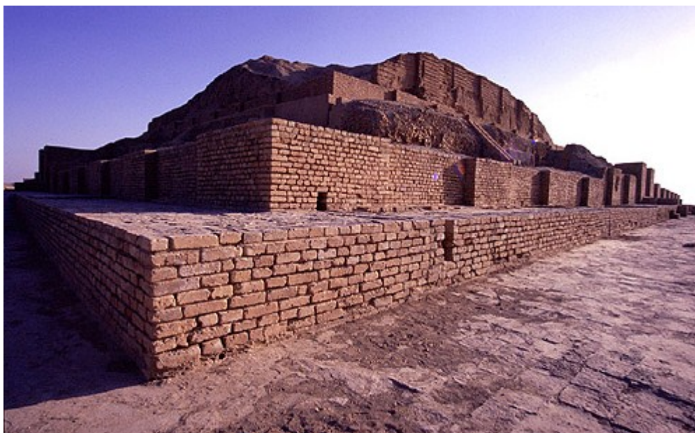
Obr. č. 2: Hliněné cihly Zikkuratu v Uru- Sumerská říše (2100 př. n. l.) [25]
