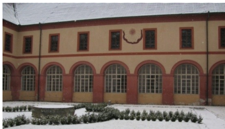
Obr. č. 46: Rajský dvůr před rekonstrukcí
