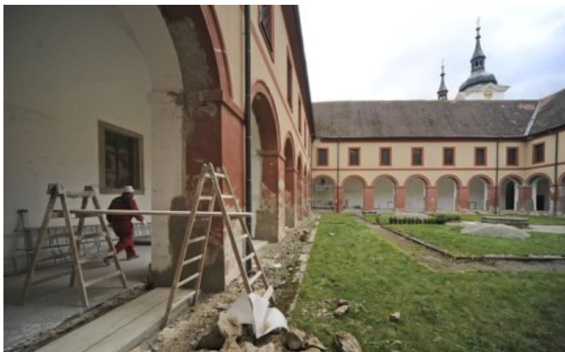
Obr. č. 47: Rajský dvůr v průběhu rekonstrukce [32]
