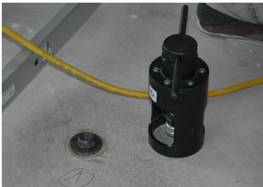
Obr. č. 38: Odrhová zkouška [40]
