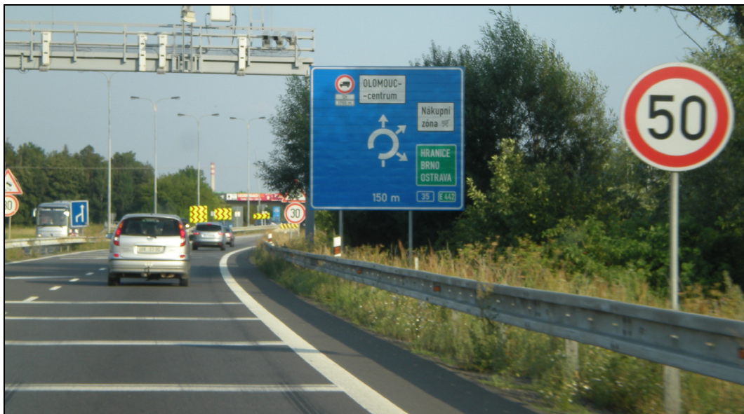
Obr.3: Snižování rychlosti na příjezdu po silnici R35 od Mohelnice k okružní křižovatce na okraji Olomouce (R35 pokračuje ostře prvním výjezdem)
